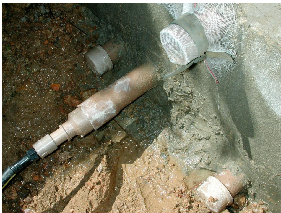
Figura 14 - Instalação da mangueira.
