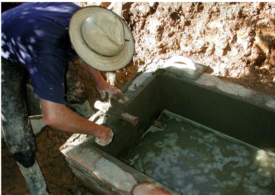
Figura 3 - Finalização da estrutura de alvenaria.
