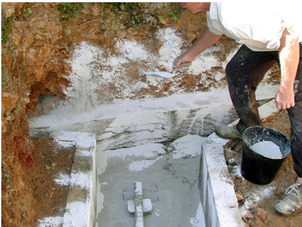
Figura 10 - Higienização da caixa de alvenaria.
