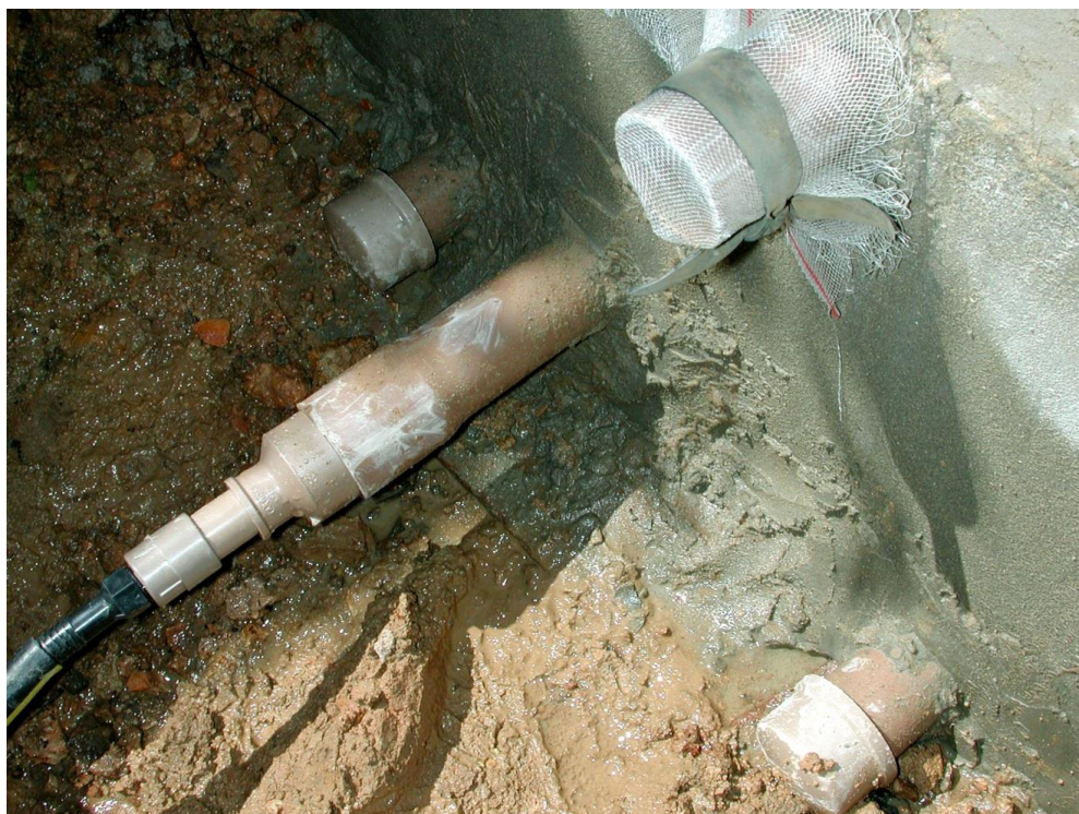
Figura 8 - Drenos de fundo, ladrão e filtro de captação na área externa.
