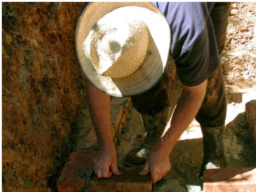
Figura 2 - Construção da estrutura física de proteção.
