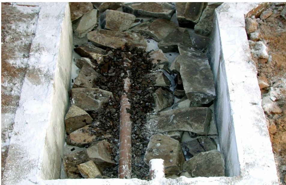
Figura 11 - Disposição das pedras na caixa de alvenaria.
