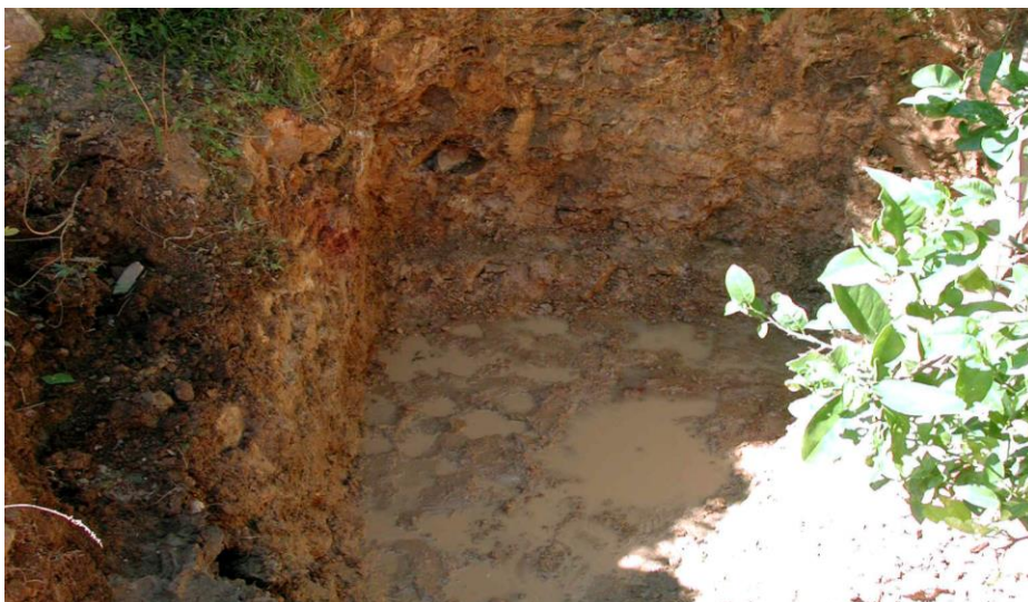
Figura 1 - Limpeza do local de afloramento da nascente.
