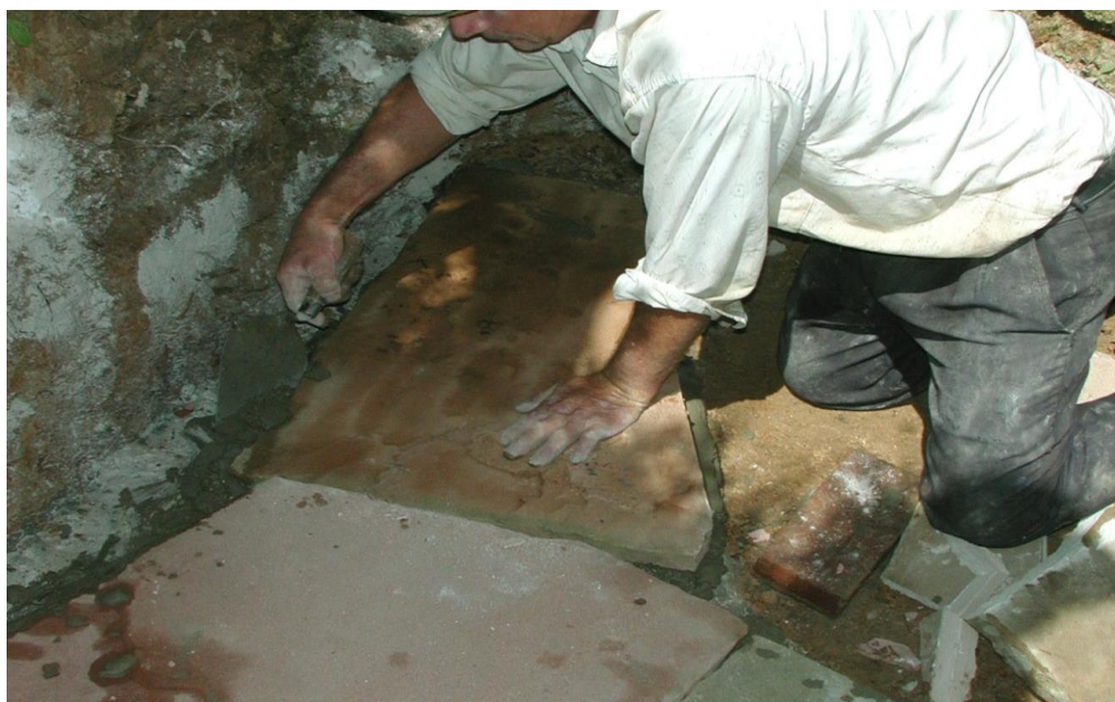
Figura 13 - Fechamento da caixa de alvenaria.
